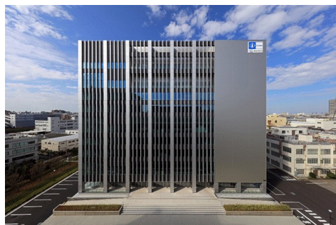
浮間工場（東京） 〔治験用/商用バイオ原薬製造〕 〔商用注射剤製造〕 〔治験用（固形剤/注射剤）製造〕
